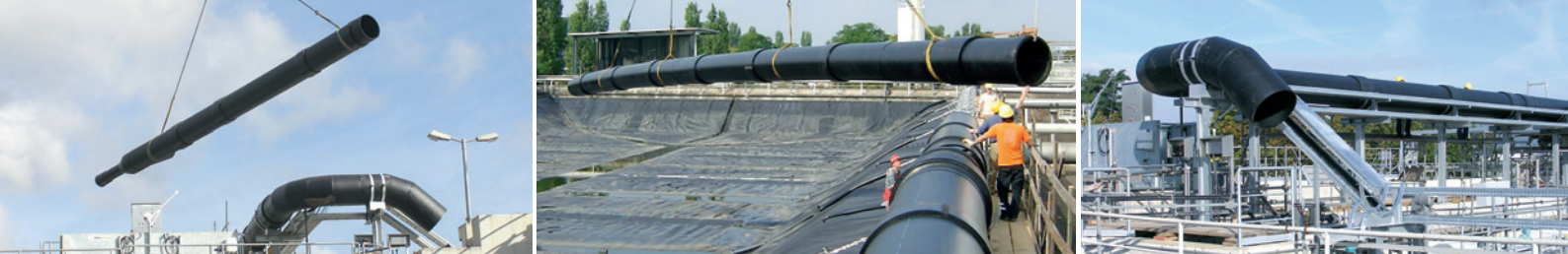
Abb. v.l.n.r.: Mühelos hebt ein 250-Tonnen-Autokran mit einer maximalen Ausladung von 70 Metern die Elemente. Bereits vorgeschweißte Rohrelemente verkürzen die Montagezeit.
