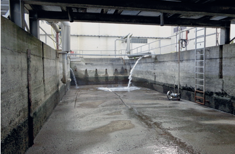
Zustand des Abwasserbeckens vor der Sanierung
