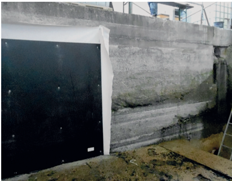
Montage von Schutzvlies und PE-Platten mittels Verdübelung auf dem Betonuntergrund
