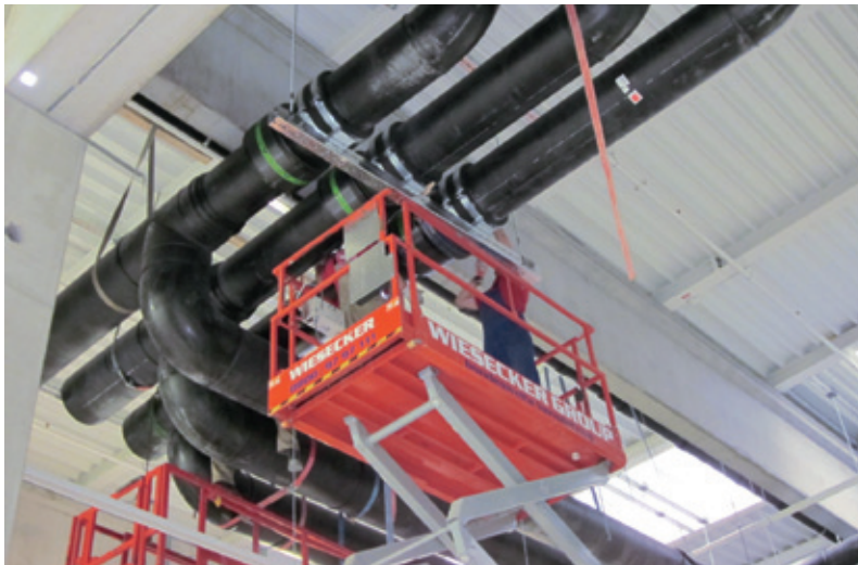
Montage von PE-HD Rohren da 400 – da 500 an der Hallendecke in ca. 8 m Höhe, Befestigung mittels Kälterohrschellen und M16 Gewindestäben an Centum-Profilen
