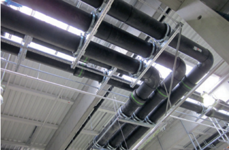
Fertige Leistung: Rohrleitungsbau im 2. Zwischengeschoss
